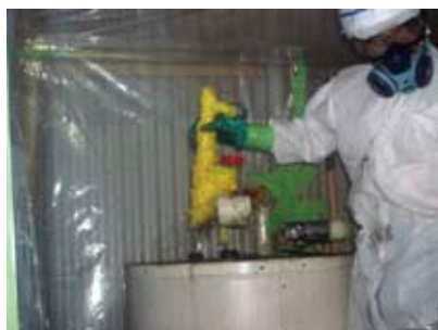
鶴ヶ峰工場 アスベスト撤去工事
